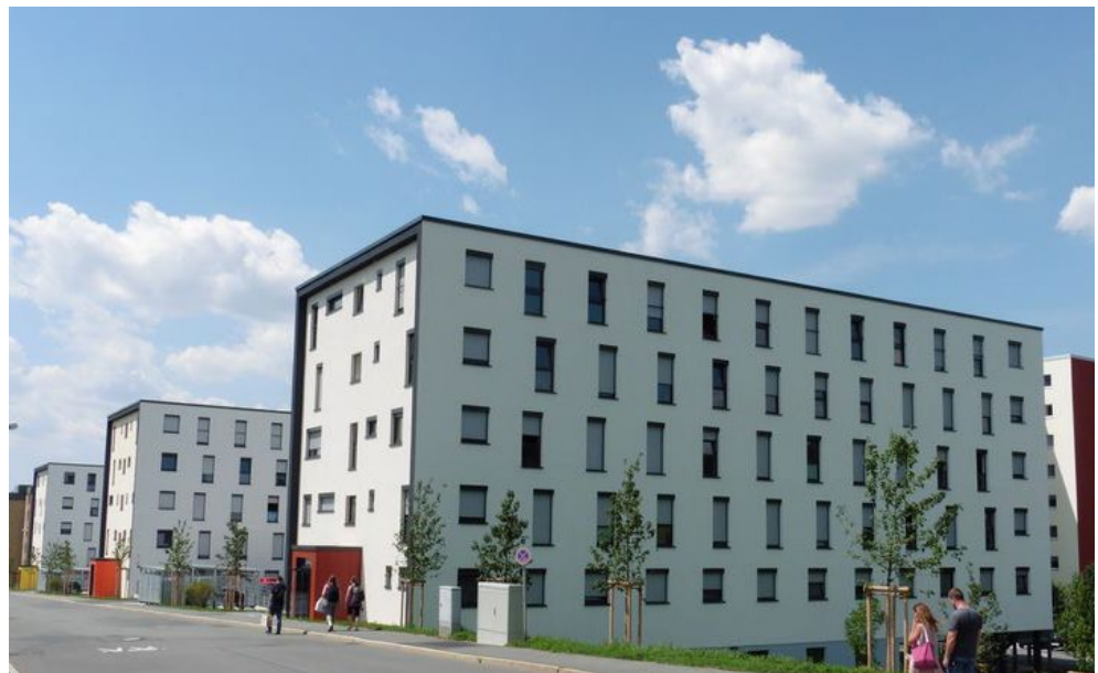
Abb. 15: Ansicht der drei neuen Wohnheime N, O und P in unmittelbarer Nähe des Campus
