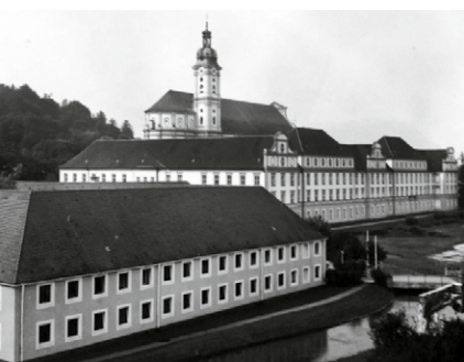
Abb. 2: Aufnahme des Standorts Fürstenfeldbruck nach Fertigstellung eines Neubaus aus dem Jahr 1965
